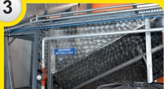
3 Transport osadów przenośnikiem ślimakowym do zbiornika retencyjnego a następnie przenośnikiem z płaszczem podgrzewanym do suszarki dyskowej
